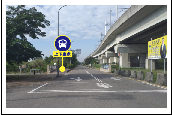
台灣高鐵彰化站橋下 ( 高鐵二路二段/ 大社路路口 )
